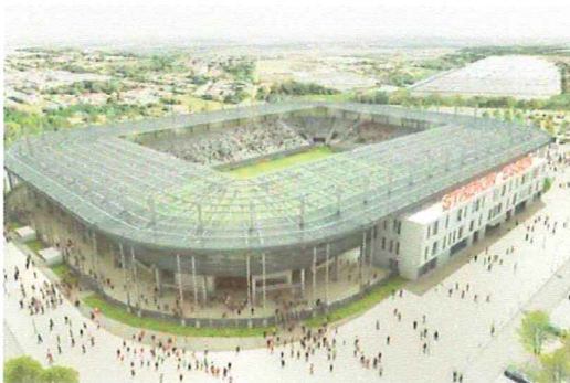
Das neue RWE Stadion (Foto: GVE Grundstücksverwaltung Stadt Essen GmbH)
