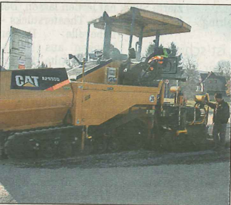
Mit dem Straßenkettenfertiger ist das Unternehmen Köster vor Ort.
