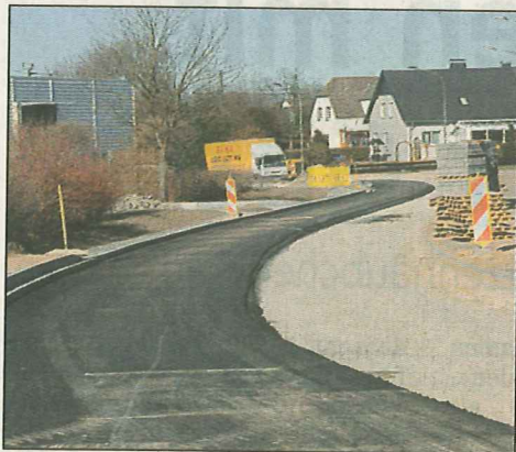
Die eine Hälfte der Fahrbahn ist bereits asphaltiert worden.
