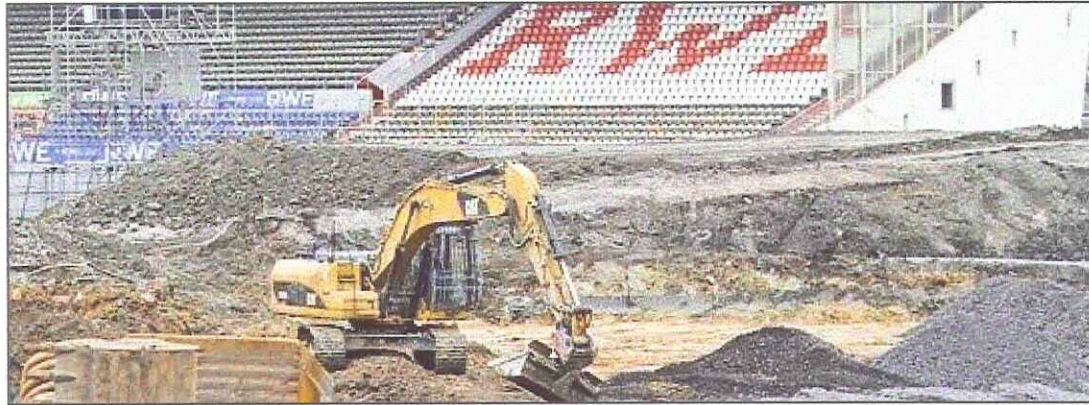
Die Bauarbeiten für das neue RWE-Stadion begonnen. Foto: Alexandra Umbach
