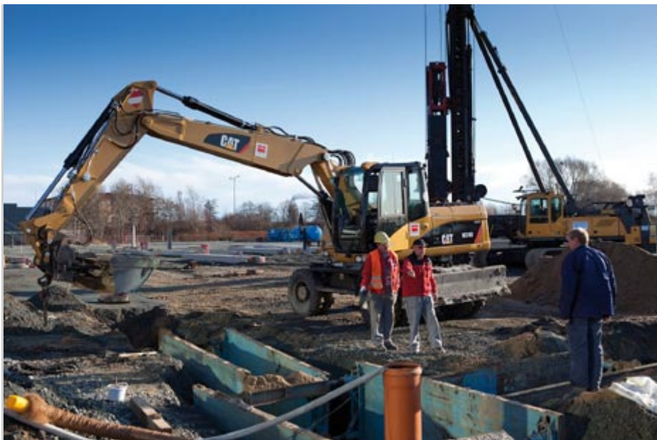
Die Fertigbetonpfähle rammt die Köster GmbH tief in den Boden, um die Lasten des Gebäudes gleichmäßig zu verteilen.
