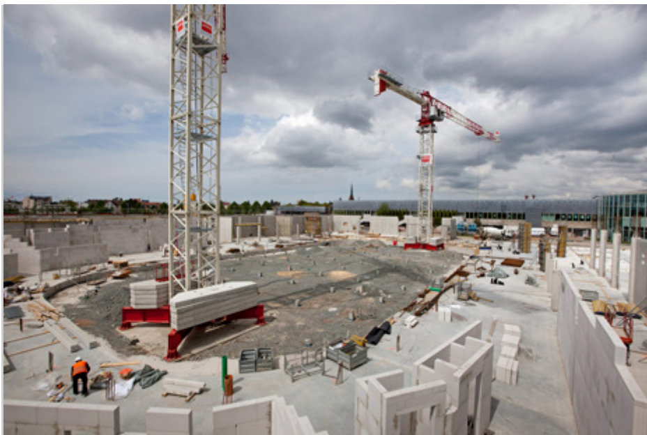
Nach der Grundsteinlegung im Frühling 2010 arbeiten derzeit rund 100 Bauspezialisten mit Hochdruck an der Realisierung der Eissporthalle
