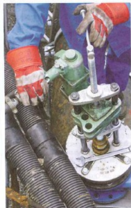
Die bestehende Graugussleitung musste durchtrennt werden, um die Kunststoffleitung anzubinden.
