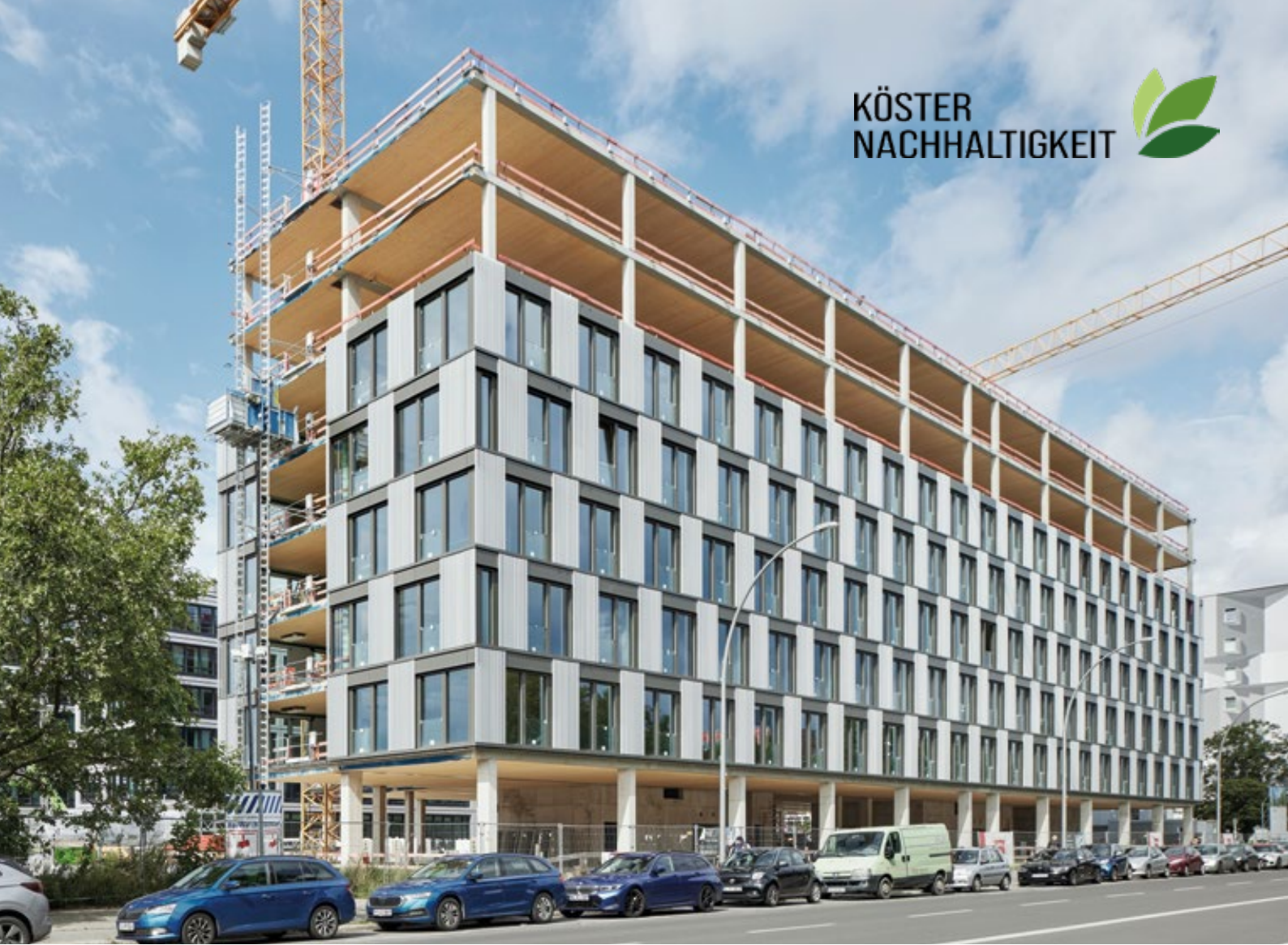
„Spark“, Berlin Achtgeschossiges Bürogebäude 14.000 m 2 Mietfläche Decken in Holzhybridbauweise
