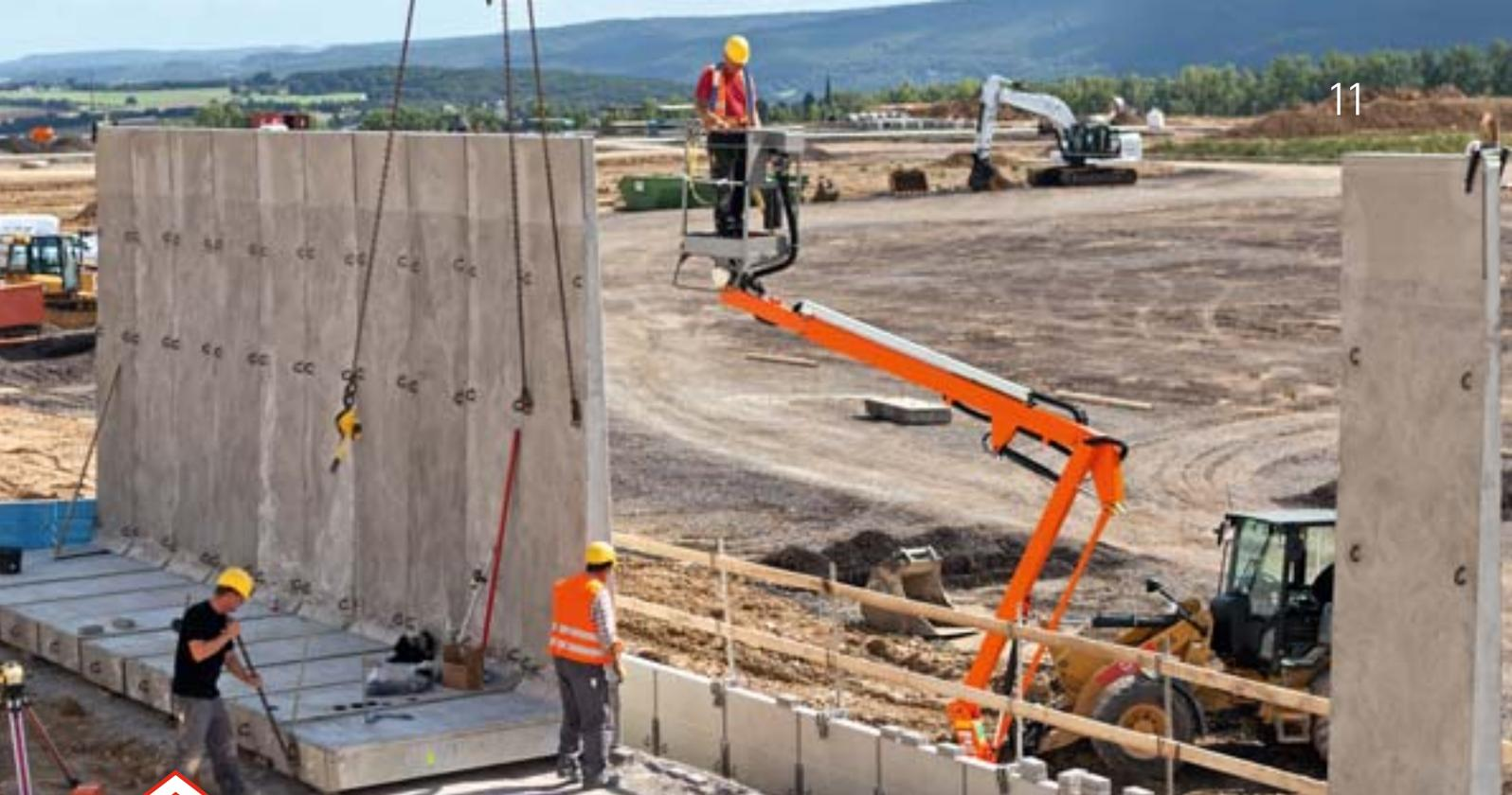
Insgesamt 145 m Länge misst die Stützwand aus Stahlbeton, die die Bauspezialisten im neuen Innovationspark errichten.
