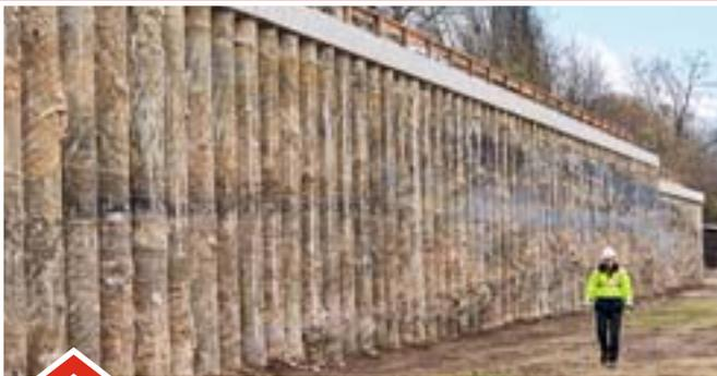
**HELIOS Klinikum Duisburg GmbH, Duisburg, dauerhafte Sicherung von Geländesprüngen/Hängen mittels Großbohrpfählen.**
