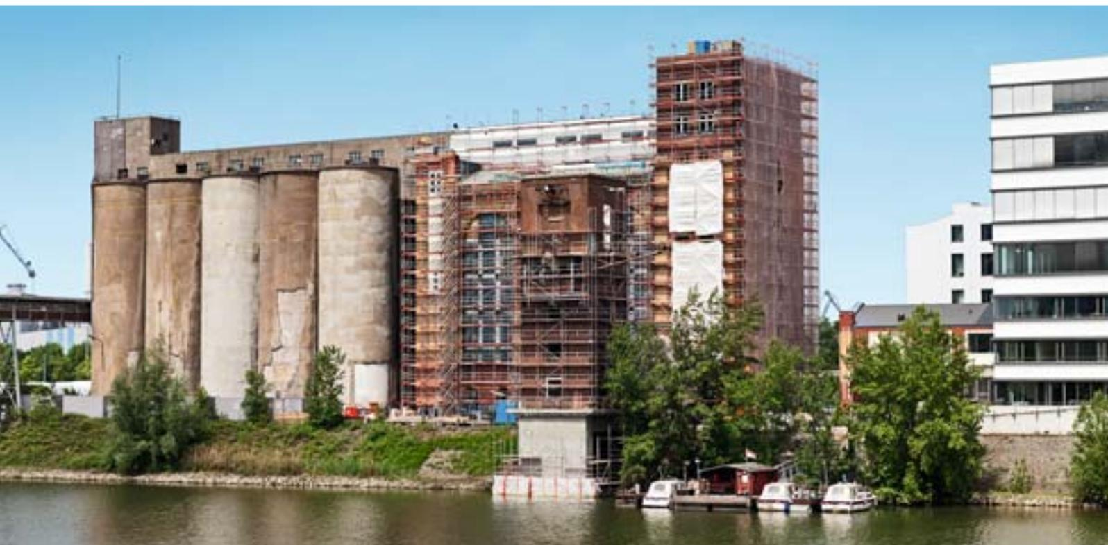
**Plange Mühle, Düsseldorf** – schlüsselfertige Sanierung und Umbau einer denkmalgeschützten Siloanlage aus dem Jahr 1906 in ein Büro- und Geschäftshaus. Während des Teilabbruchs sichern die Bauexperten Teile der Ziegelfassade, arbeiten Bauteile auf und integrieren diese wieder. Aus statischen Gründen wird der Dachstuhl neuwertig nachgebaut. Ein umfangreicher Hochwasserschutz sichert die Baustelle am Hafenbecken.
