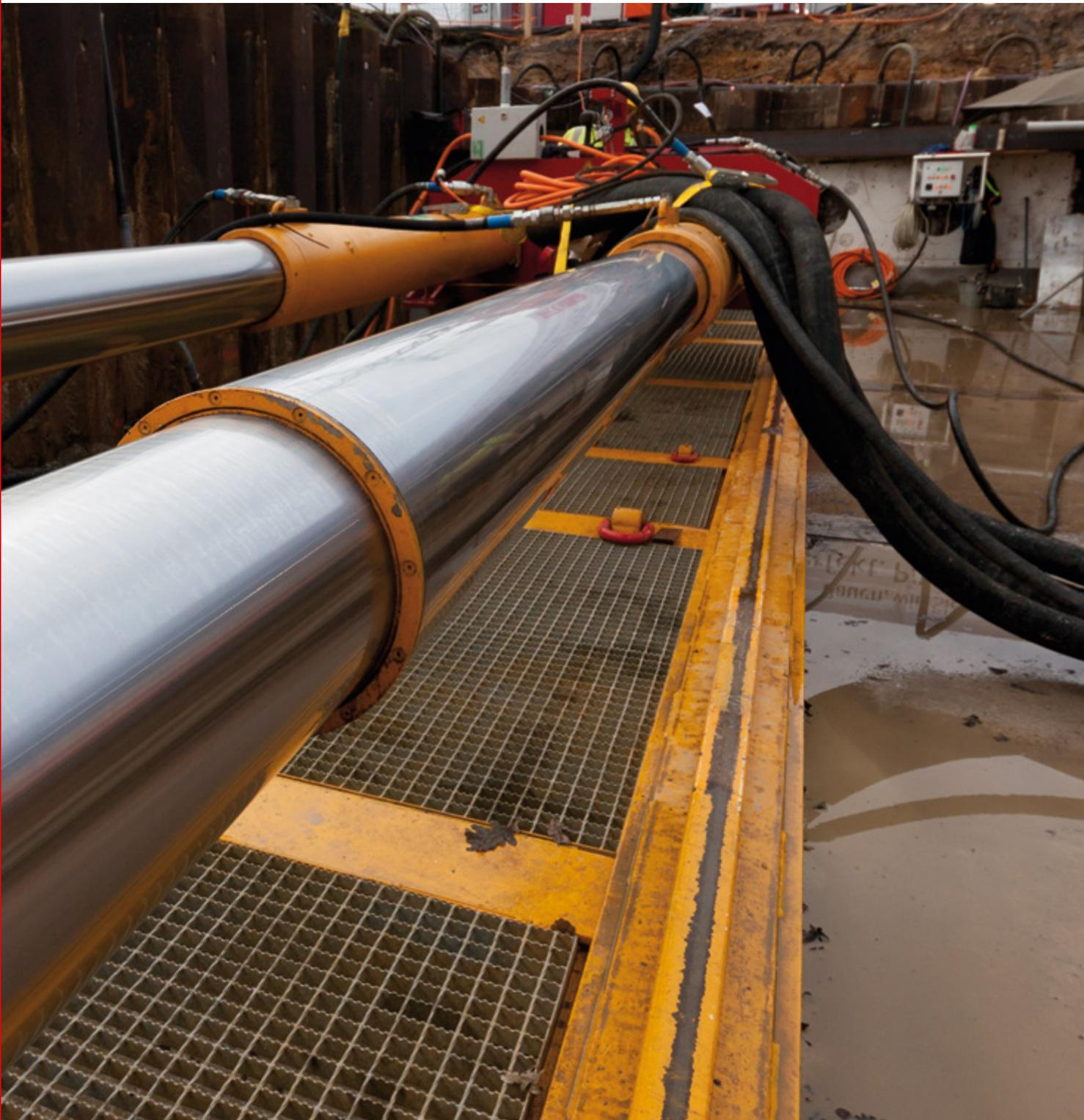
Die Rohrleitungsbauspezialisten von Köster setzten das „E-Power Pipe®“-Verfahren weltweit als erstes Bauunternehmen ein und erprobten es gemeinsam mit der Herrenknecht AG und einem Übertragungsnetzbetreiber zur Installation von Kabelschutzrohren für eine 220 kV-Höchstspannungsleitung.
