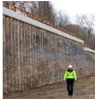
HELIOS Klinikum Duisburg GmbH, Duisburg, dauerhafte Sicherung von Geländesprüngen/Hängen mittels Großbohrpfählen.
