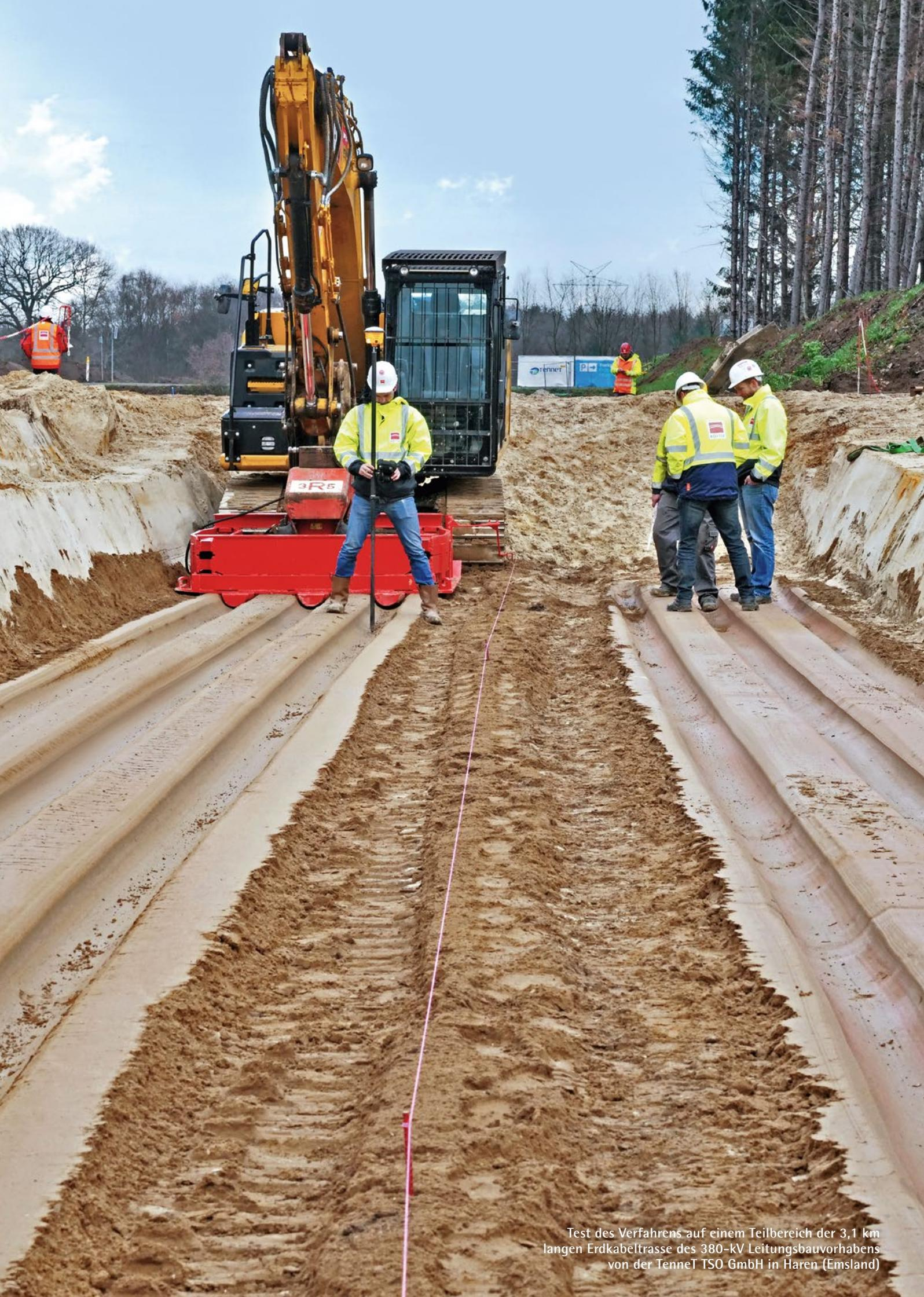
Test des Verfahrens auf einem Teilbereich der 3,1 km langen Erdkabeltrasse des 380-kV Leitungsbauvorhabens von der TenneT TSO GmbH in Haren (Emsland)
