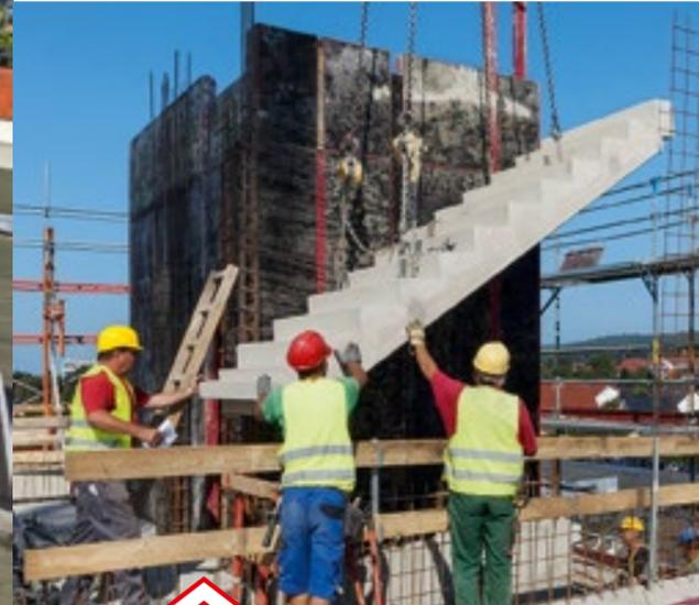
Mit dem Einsatz von Betonfertigteilen verkürzt das Köster-Team die Bauzeit für die anspruchsvolle Stahlbetonskelettbauweise. Auch hier wird ein besonders hochwertiger Beton verwendet, dessen Qualität bereits im Werk kontrolliert wird.
