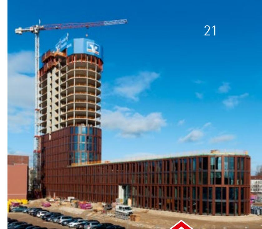
einem Jahr Bauzeit den kompletten Rohbau für den 120 m langen, fünfgeschossigen Sockelbau und den 70 m hohen, 19-geschossigen Büroturm mit insgesamt 19.000 qm Bruttogeschossfläche fertigstellen. Einen Beitrag dazu leistete das Schalungskonzept mit einer Paneel-Deckenschalung und einer Kletterschutzwand, das optimal auf die Projektanforderungen abgestimmt war.
