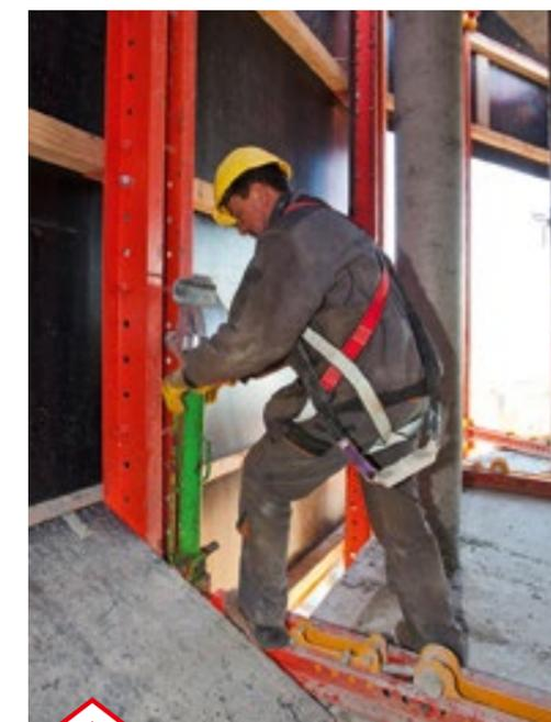
Über eine Schienenführung mit Kletterhydraulik konnten sowohl die Paneel-Deckenschalung als auch die Kletterschutzwand ohne Kran umgesetzt werden.
