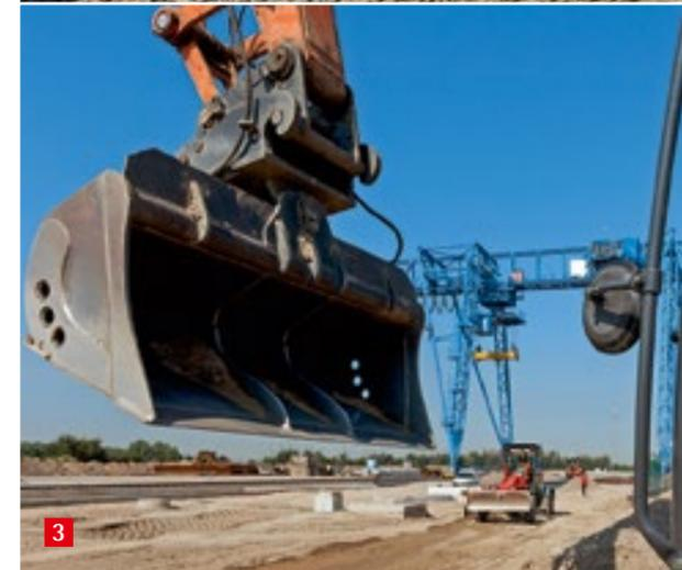
Die Köster-Mannschaft erneuert den Kranbahnkran auf einer Länge von 285 m **1** und realisiert insgesamt 32.750 qm befestigte Verkehrsflächen mit Asphalt- bzw. Stahlbetonbelag **2**. Für die Erneuerung der Portalkranbahn **3** baute die Köster GmbH das vorhandene Kranbahnfundament zurück und stellte es im Anschluss auf einer Länge von 335 m neu her.
